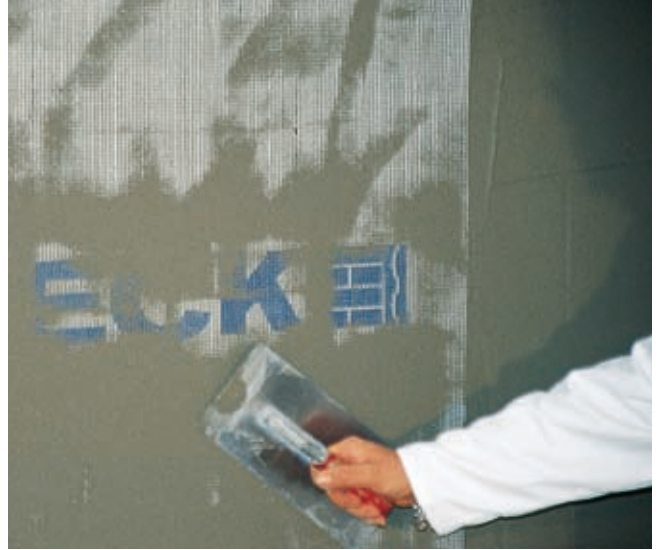
② HECK AGG (Armierungsgewebe fein) in frischer Masse einbetten.
