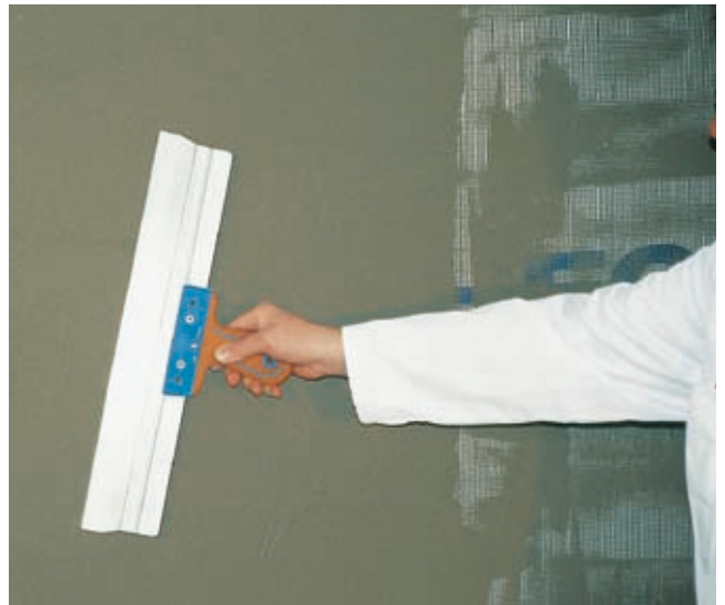
④ Oberfläche der frischen Armierungsschicht eben abziehen.
