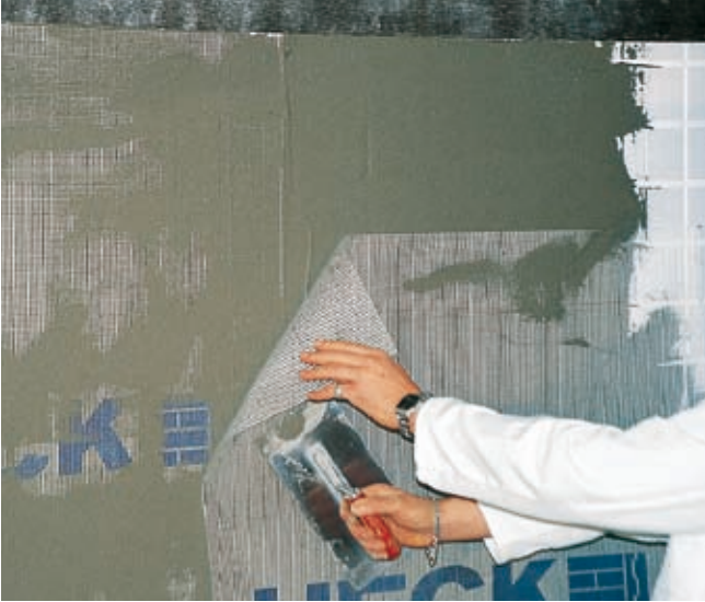
① HECK K+A auf Dämmplatte aufbringen.
